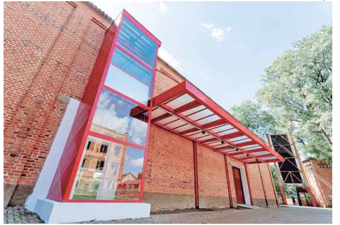
Elevador panorâmico dá acessibilidade inédita à Pinacoteca
